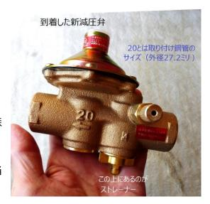
4.12月5日朝、3本の大中小サイズのパイプレンチを用意して旧弁の取り外しにかかる。しかし 固く締まりきった鋼管ネジ部はウンともスンとも動かない。そこで同じ住宅に住む友人に電話して 来てもらい、二人がかりで何とか配管を分解する。
